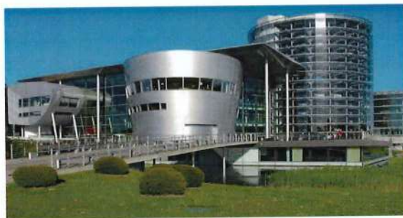
Hình 44. Nhà xưởng hợp khối cao tầng
