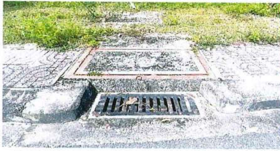
Hình 25. Hồ ga thu nước mưa
