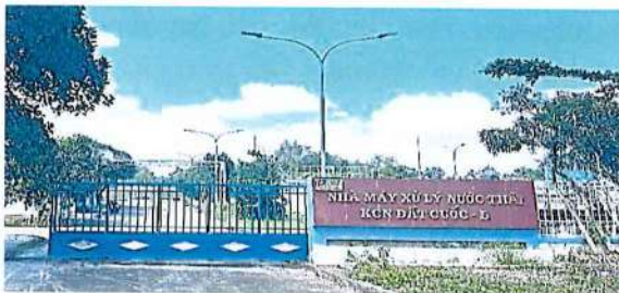
Hình 27. Trạm xử lý nước thải
