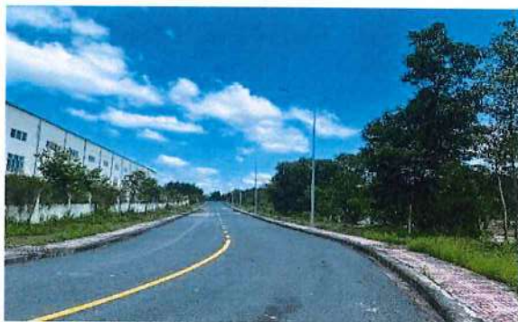
Hình 21. Đường N1 nối dài (Khu A)
